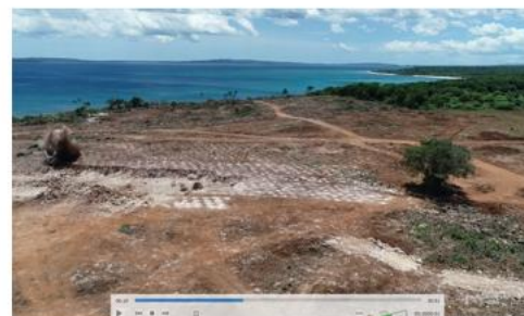
Inisiasi awal pada detik ke 19 dan terlihat lubang pertama meledak
