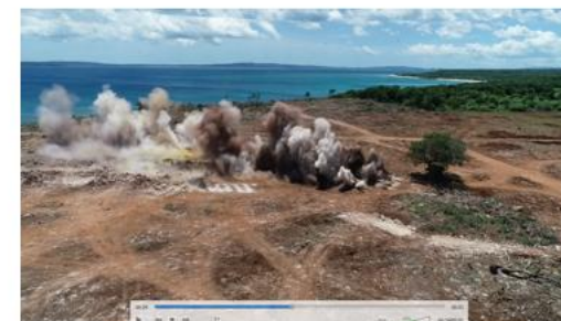
Pada detik ke 24 atau setelah 5 detik dari awal durasi seluruh lubang telah meledak. Terlihat debu dan fumes.
